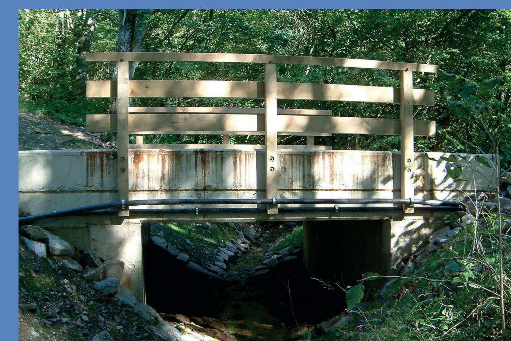
Neu angelegte Brücke mit rauer naturnaher Sohle. Die Fließgeschwindigkeit wird reduziert. Der Bach ist für Wasserlebewesen vollständig Richtung Quelle durchwanderbar.
